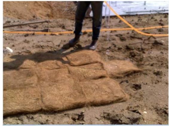
gambar 13 : Proses menyiram pallet yang telah disusun
