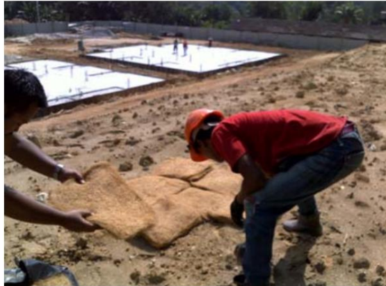
Gambar 12 : Proses meletakkan dan menyusun pallet
