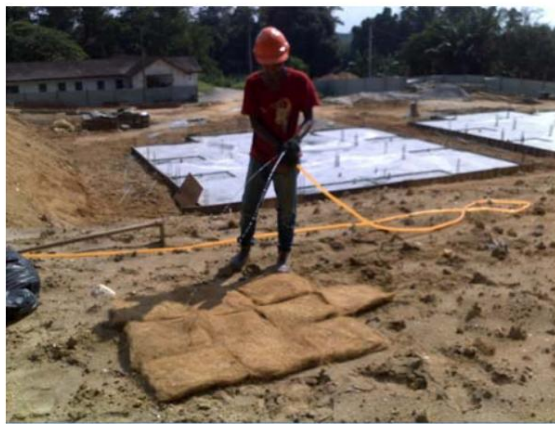
gambar 13 : Proses menyiram pallet yang telah disusun
